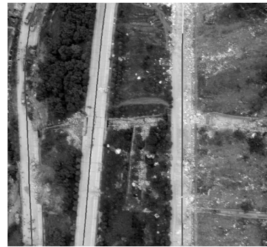
图 4 北川地区影像的道路损毁检测结果
